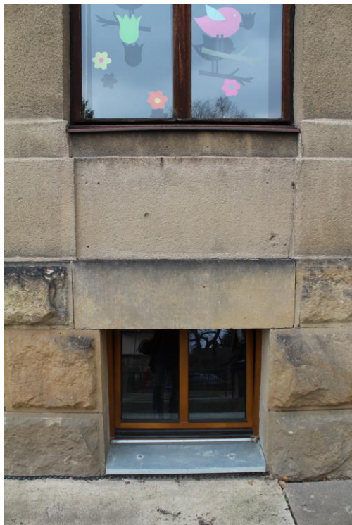
obr. 13 - detail soklové části s překladem okna v 1.PP
